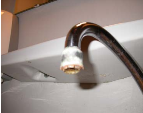
Brise jet couvert de calcaire
