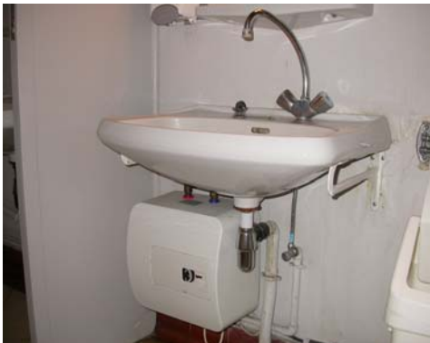
Chauffe-eau électrique juste avant le robinet
